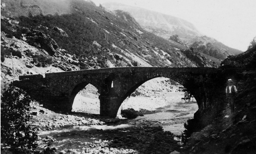
FIGURA 5. Puente romano de Compuerto
