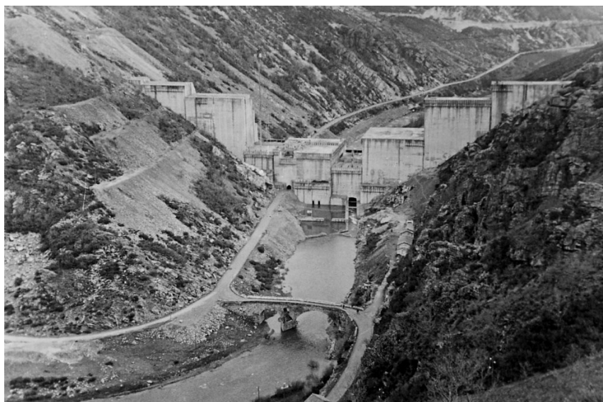
FIGURA 2. Imagen del puente romano durante la construcción de la presa
